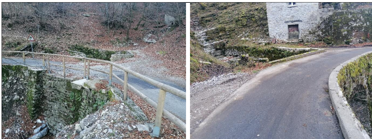
Figura: Nel tratto certificato, presso gli affluenti laterali, il CMABM è responsabile della pulizia degli imbocchi e degli sbocchi dei manufatti di attraversamento stradale. Non si tratta di camere di ritenuta, ma di semplici tratti di deposito del materiale. Le cubature estratte non sono rilevanti ai fini del bilancio del materiale solido di fondo (esempi: in Valle della Crotta: sinistra, coord.: 2°725'355, 1°082'768; destra, coord.: 2°726'375, 1°083'396).
