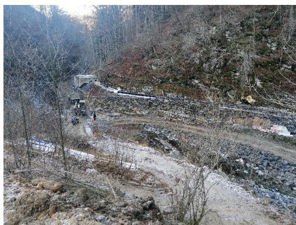
Figura: a sinistra, bauletto in calcestruzzo e palificata in legno sul torrente Breggia a Muggio in corrispondenza della vasca antincendio (coord.: 2°724'165, 1°085'015); a destra: consolidamento di versante in prossimità della captazione ad uso potabile in Valle della Crotta, con pista di cantiere temporanea (2°726'560, 1°083'565).
