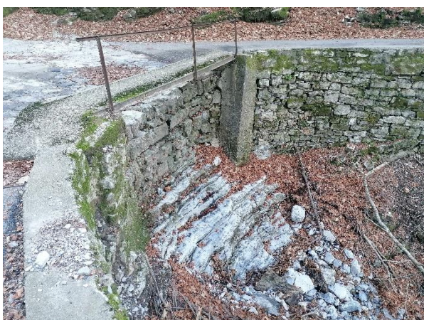
Figura: Salti di fondo nel bacino certificato . A sinistra, ostacolo < 50 cm sul torrente Luasca non piscicolo (tra Cabbio e Muggio, coord.: 2°724'560, 1°084'315). Destra: salto di fondo in Valle della Crotta (2°725'663, 1°083'120).
