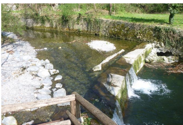
Figura: Salti di fondo nel Piano di sviluppo . A sinistra, briglia storica in muratura "Punt dala Ciüsa" nel Piano di Sviluppo (2°722'330, 1°079'575). Essa alimentava le rogge molinare del comparto ex-Saceba; si tratta dell'unico ostacolo rilevante (> 50 cm) per la migrazione ittica nell'asta principale del torrente Breggia; un canale di bypass permetterebbe di ripristinare la percorribilità ittica, ma esso è incompleto. Destra: Salto di Birra in un tratto con arginatura, ca. 100 cm (località ex- Rolla, coord.: 2°722'281, 1°079'082).
