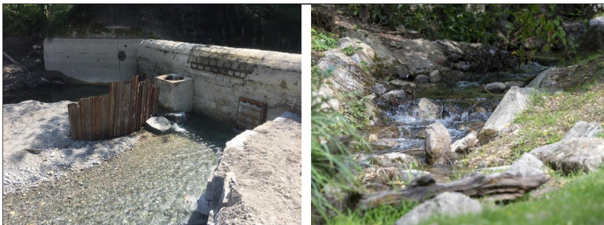
Figura: Salti di fondo a valle del Piano di sviluppo: briglia del Laghetto del Ghitello (coord.: 2'722'208, 1'078'773). A destra, canale di bypass per pesci che permette la risalita della fauna ittica.
