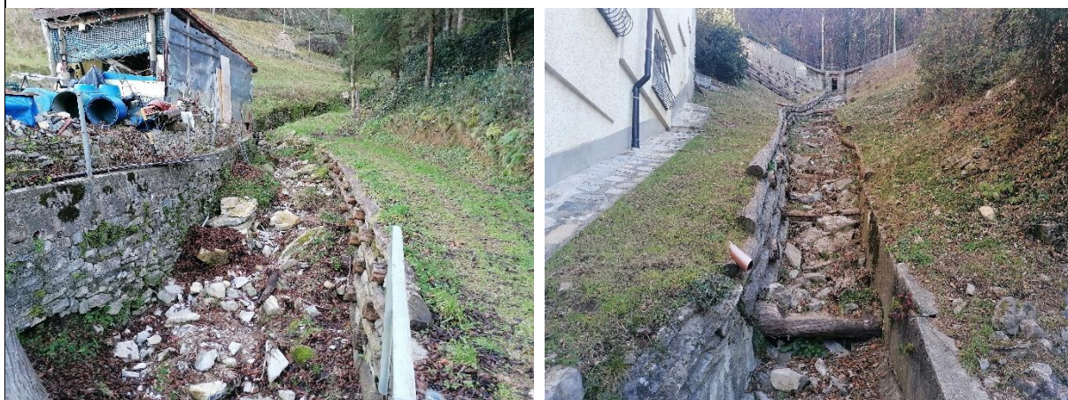
Figura: Tratti rettificati in prossimità dei tombinamenti della strada cantonale. A sinistra: Caneggio (coord.: 2'723'790, 1'080'850), a destra: Cabbio (coord.: 2'724'707, 1'083'969). Entrambi questi affluenti sono stati esclusi dalla certificazione a causa della discontinuità verso valle causata proprio dall'intubamento del corso d'acqua.
