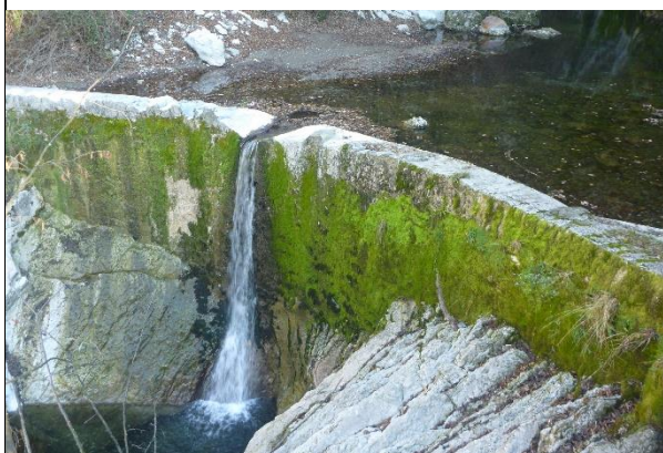
Figura: Salti di fondo nel Piano di sviluppo . A sinistra, briglia storica in muratura "Punt dala Ciüsa" nel Piano di Sviluppo (2°722'330, 1°079'575). Essa alimentava le rogge molinare del comparto ex-Saceba; si tratta dell'unico ostacolo rilevante (> 50 cm) per la migrazione ittica nell'asta principale del torrente Breggia; un canale di bypass permetterebbe di ripristinare la percorribilità ittica, ma esso è incompleto. Destra: Salto di Birra in un tratto con arginatura, ca. 100 cm (località ex- Rolla, coord.: 2°722'281, 1°079'082).
