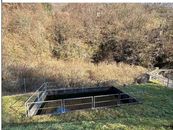
Figura: Vasca antincendio in località San Giovanni (Muggio), con volume d'accumulo di ca. 100 m 3 e relativa condotta di pompaggio dal fiume (tracciato evidenziato in rosso).
