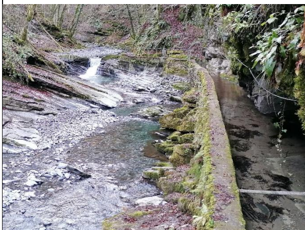
Figura: Salto di fondo nel bacino certificato . Mulino di Bruzella (2°724'452, 1°083'106): briglia storica in muratura per l'alimentazione della roggia molinara nel tratto terminale della Valle della Crotta. La briglia sfrutta un ostacolo in roccia naturale (in giallo > 50 cm), sopra cui sono state edificate le ali della briglia (in rosso, < 50 cm). In corrispondenza della gàveta, l'altezza artificiale rispetto alla roccia naturale è minima (< 50 cm).
