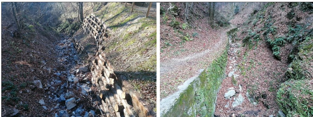
Figura: Esempi di tratti rettificati nel reticolo certificato. A sinistra: palificata in legname a Uggine (coord.: 2'725'850, 1'083'853); a destra: muro di sostegno del camminamento in Val di Scarp a Bruzella (coord.: 2'724'232, 1'082'072).
